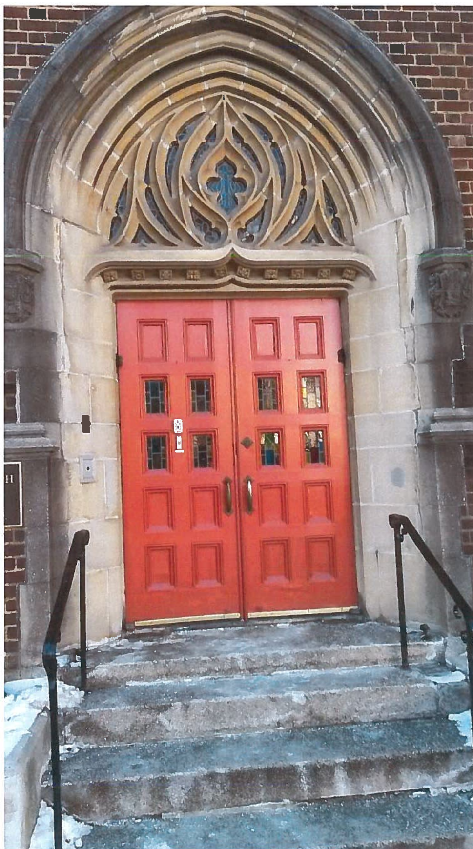
UUCLV Wall Street Door
